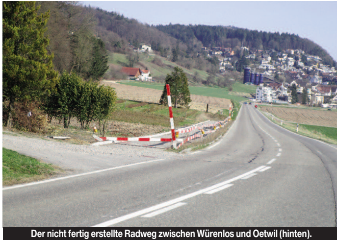
Der nicht fertig erstellte Radweg zwischen Würenlos und Oetwil (hinten).
