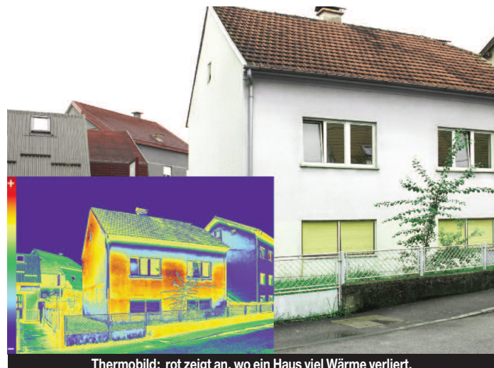
Thermobild: rot zeigt an, wo ein Haus viel Wärme verliert.
